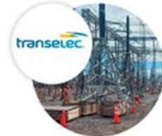
Renovación Subestación Buin
